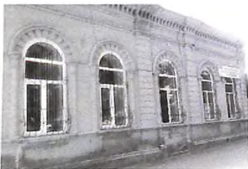
Ўзбекистон Қизил Ярим ой жамияти Самарқанд вилоят ташкилоти 1950 йилдан 1981 йилгача фаолият кўрсатган ва 1980 йилда Республика ўқув-услуг маркази ўз фаолиятини бошлаган бинонинг ташқи кўриниши.
