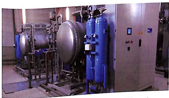
5.12-rasm. Suvni ozonlash qurilmasi
