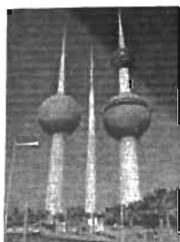
Водонапорные башни, Кувейт, конец 1970-х гг.
