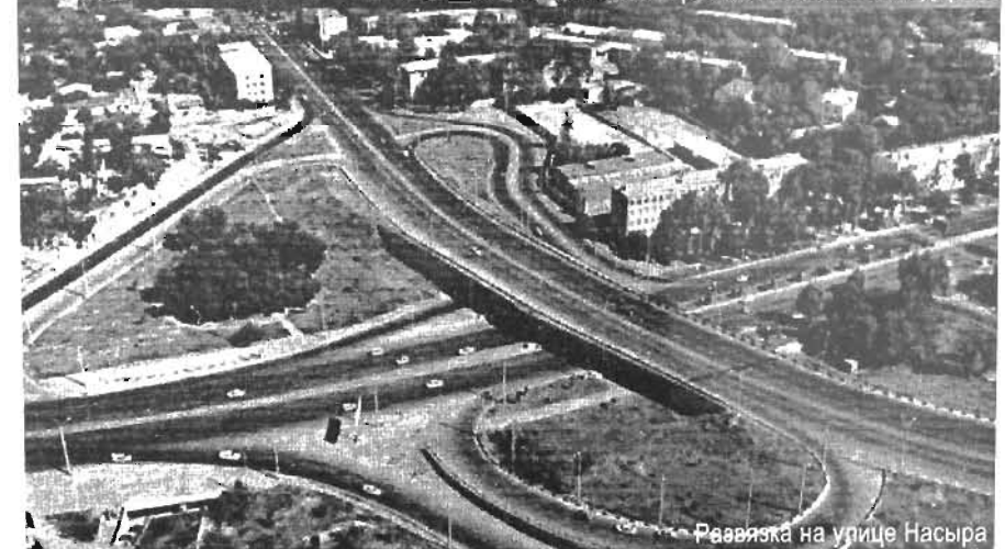
174. ТАШКЕНТ. МОСТЫ И ПУТЕПРОВОДЫ СКОРОСТНЫХ МАГИСТРАЛЕЙ. 1991-2002 ГГ.
